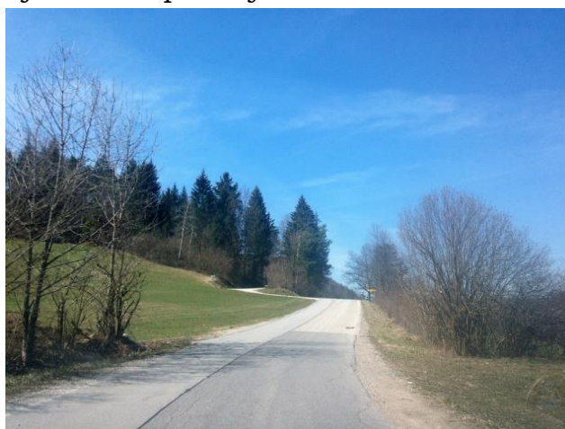
Odsek lokalne ceste med Vinicami in Lipovšico
