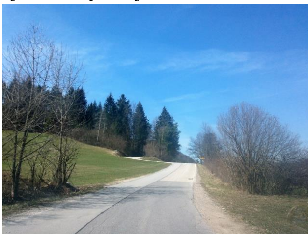
Odsek lokalne ceste med Vinicami in Lipovšico
